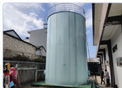
FASILITAS PENGUJIAN & KALIBRASI ALAT UKUR
